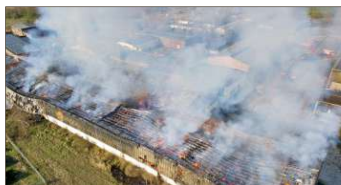
Die große Lagerhalle an der Durchfahrtsstraße stand als erstes im Vollbrand. Die Halle war bis unter das Dach mit Stroh gefüllt. Auf dem Dach war eine Photovoltaikanlage.
