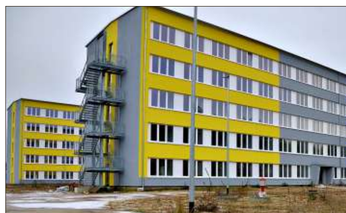
Größtes Sorgenkind: Die neue Asylunterkunft in Stendal. Baubeginn war bereits 2015, Abschlusstermin ist jetzt Anfang 2025. Foto: A. Wollmann
