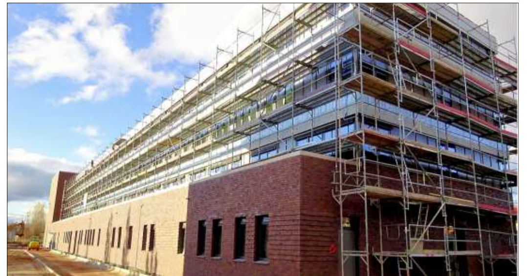
Der Neubau Landesamt für Geologie und Bergwesen in Halle entsteht auf dem Gelände der Fliederwegkaserne. Fertigstellung soll im Juni dieses Jahres sein.
