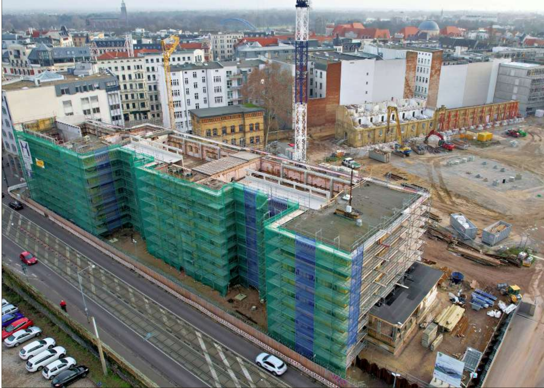
Die Sanierung und der Neubau einzelner Gebäude für die Polizeiinspektion Magdeburg in der Sternstraße gehört zu den größten laufenden Bauarbeiten des Landes. Mit einem Abschluss wird in drei Jahren gerechnet. Insgesamt wird mit einem Kostenumfang von knapp 190 Millionen Euro gerechnet.
