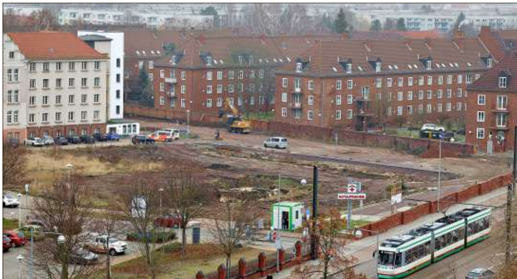
An dieser Stelle entsteht das neue Herzzentrum an der Magdeburger Otto-von Guericke-Universität bis 2026 an der Leipziger Straße. Die Kosten für den Neubau sollen sich auf rund 118 Millionen Euro belaufen.
